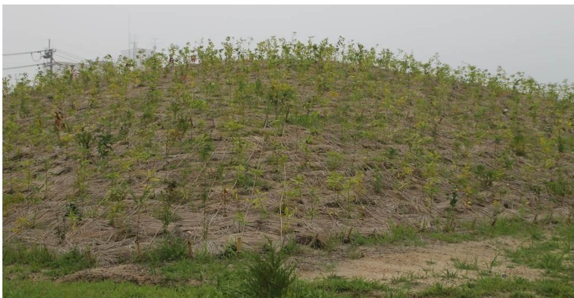
Fig. 24. Bosque de mitigación en la ciudad costera de Iwanuma, Japón. El proyecto forma parte del plan de reconstrucción urbana, post tsunami de 2011. Como se observa en la sección de abajo, el bosque se desarrolla sobre un sistemas de colinas artificiales levantadas a partir de la acumulación de escombros generados por el tsunami, los cuales son estabilizados y luego cubierto por tierra vegetal apta para recibir las plantaciones de árboles.
