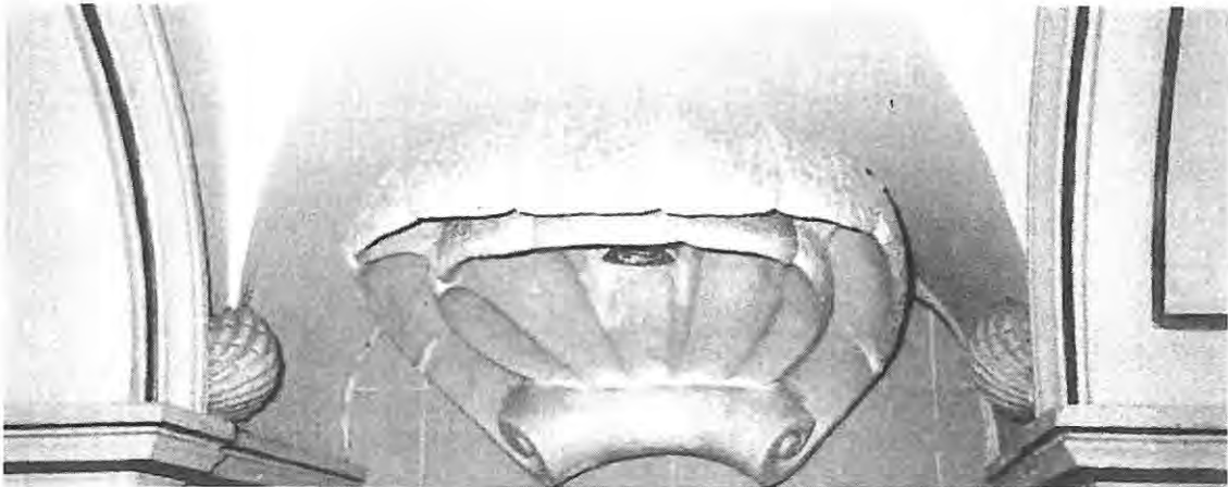
5. Detalle de la bóveda y de la gran venera que oculta la alcachofa de la ducha, así como los apliques de luz indirecta, todo ello realizado en escayola
