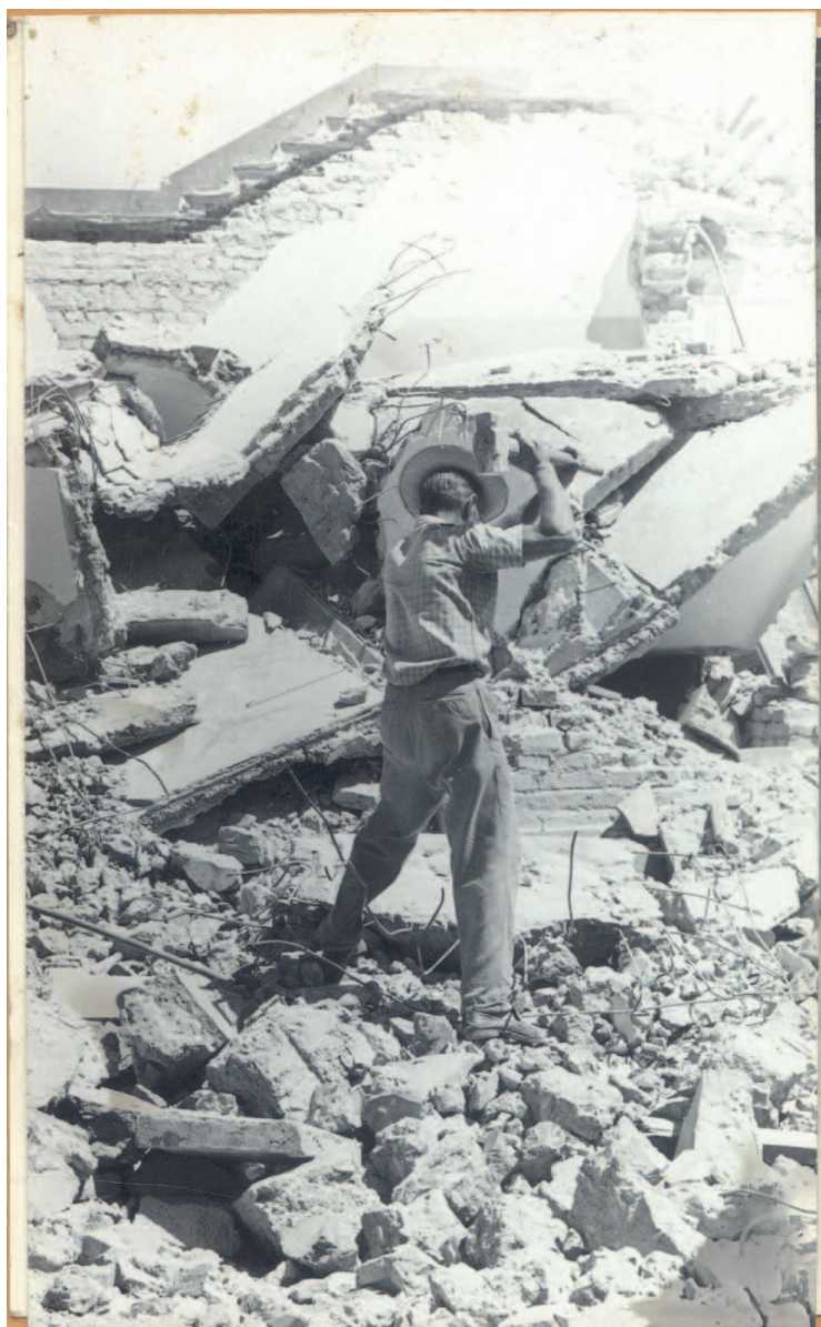
Demolição do Teatro Municipal. [Campinas/SP], 1965, V-8. Coleção Aristides Pedro da Silva (V-8) / Centro de Memória – Unicamp.
