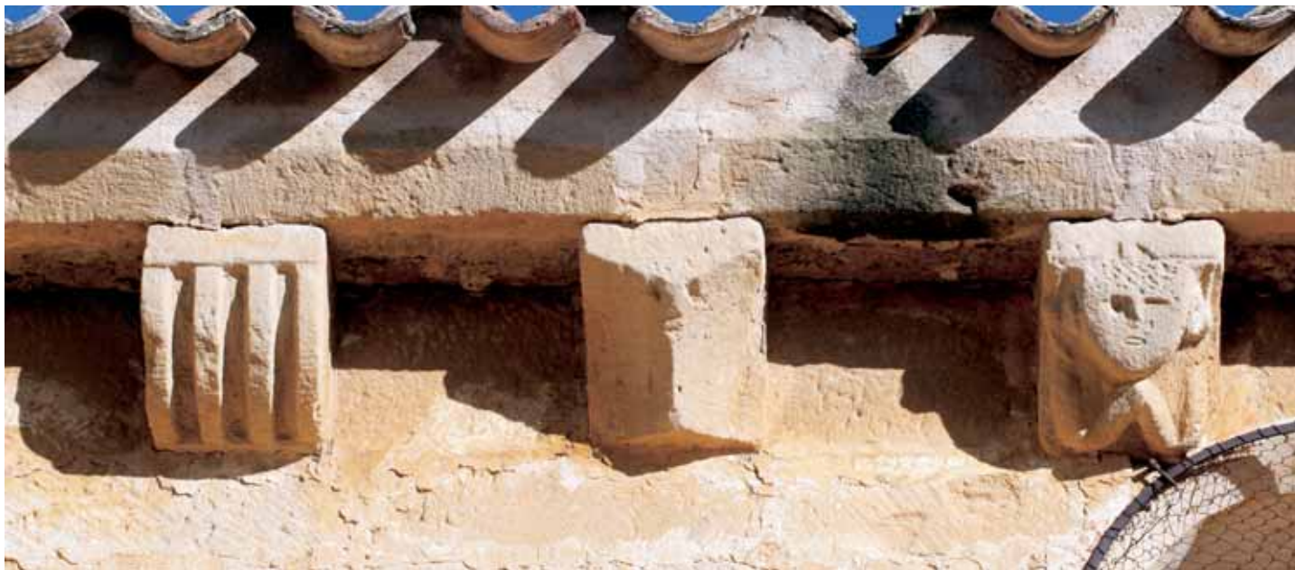
Canecillos de muro sur de la nave
