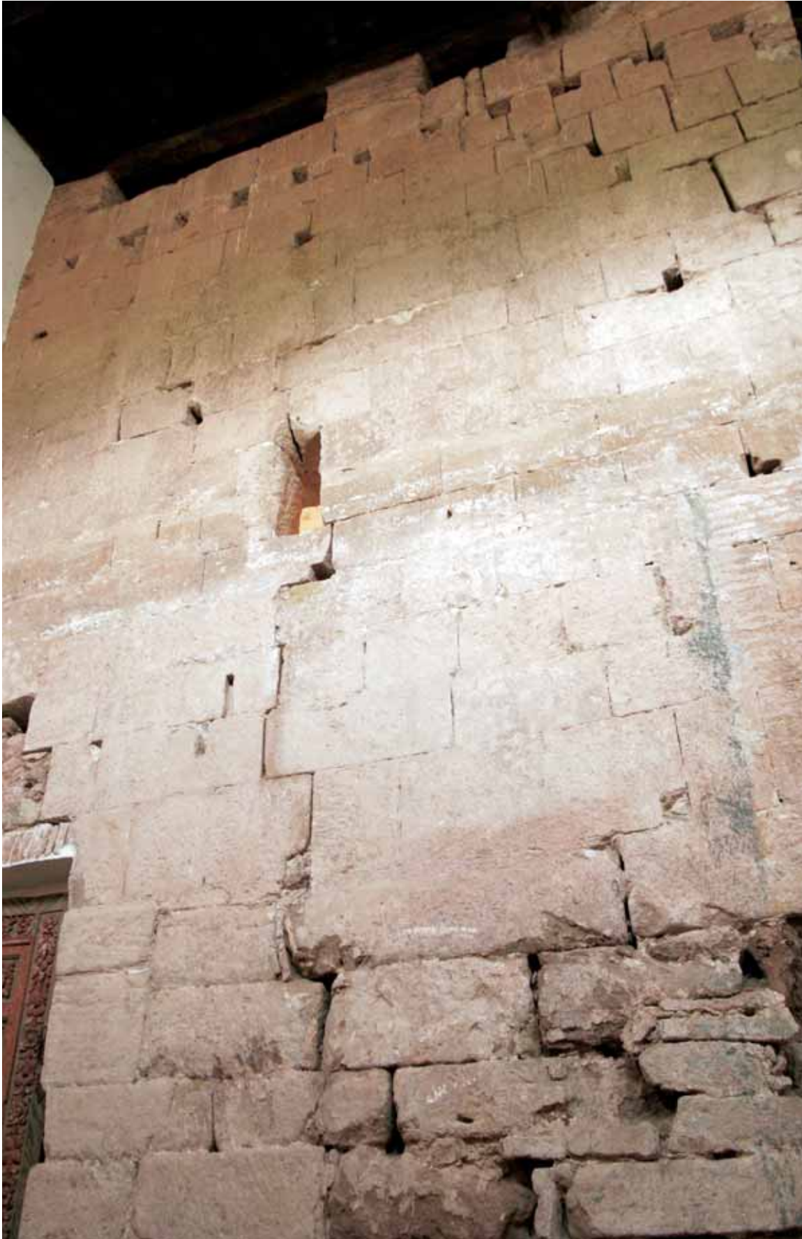
Restos de muro románico
