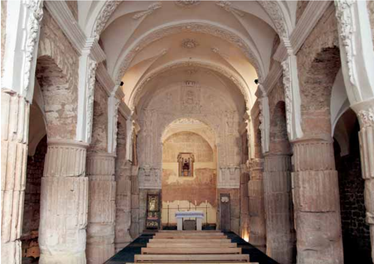
Interior de la iglesia
