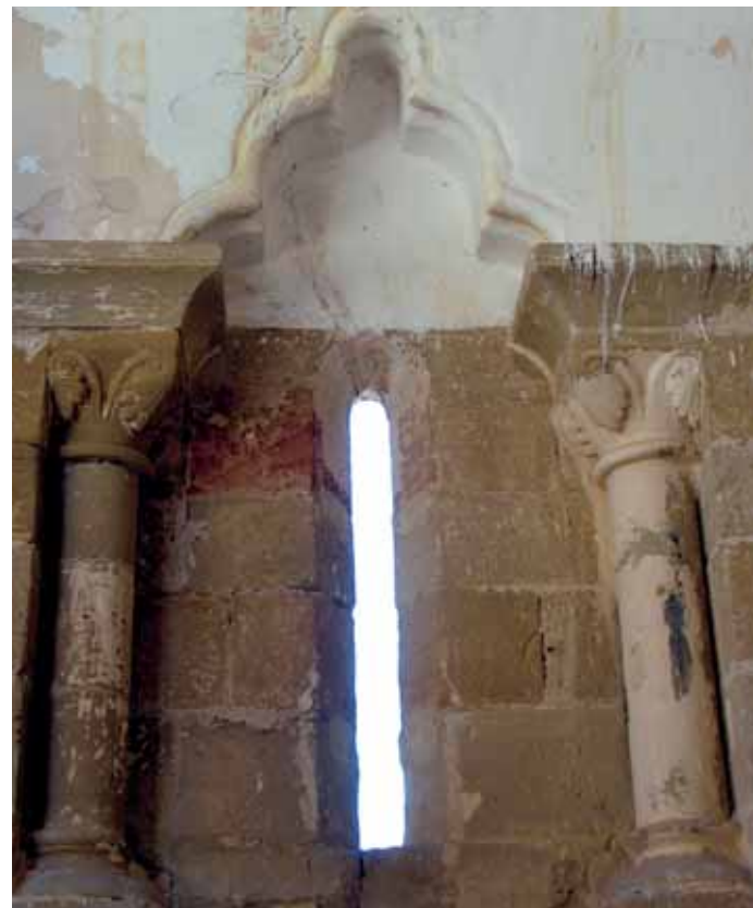
Vertiente interna de la ventana del muro norte del presbiterio
