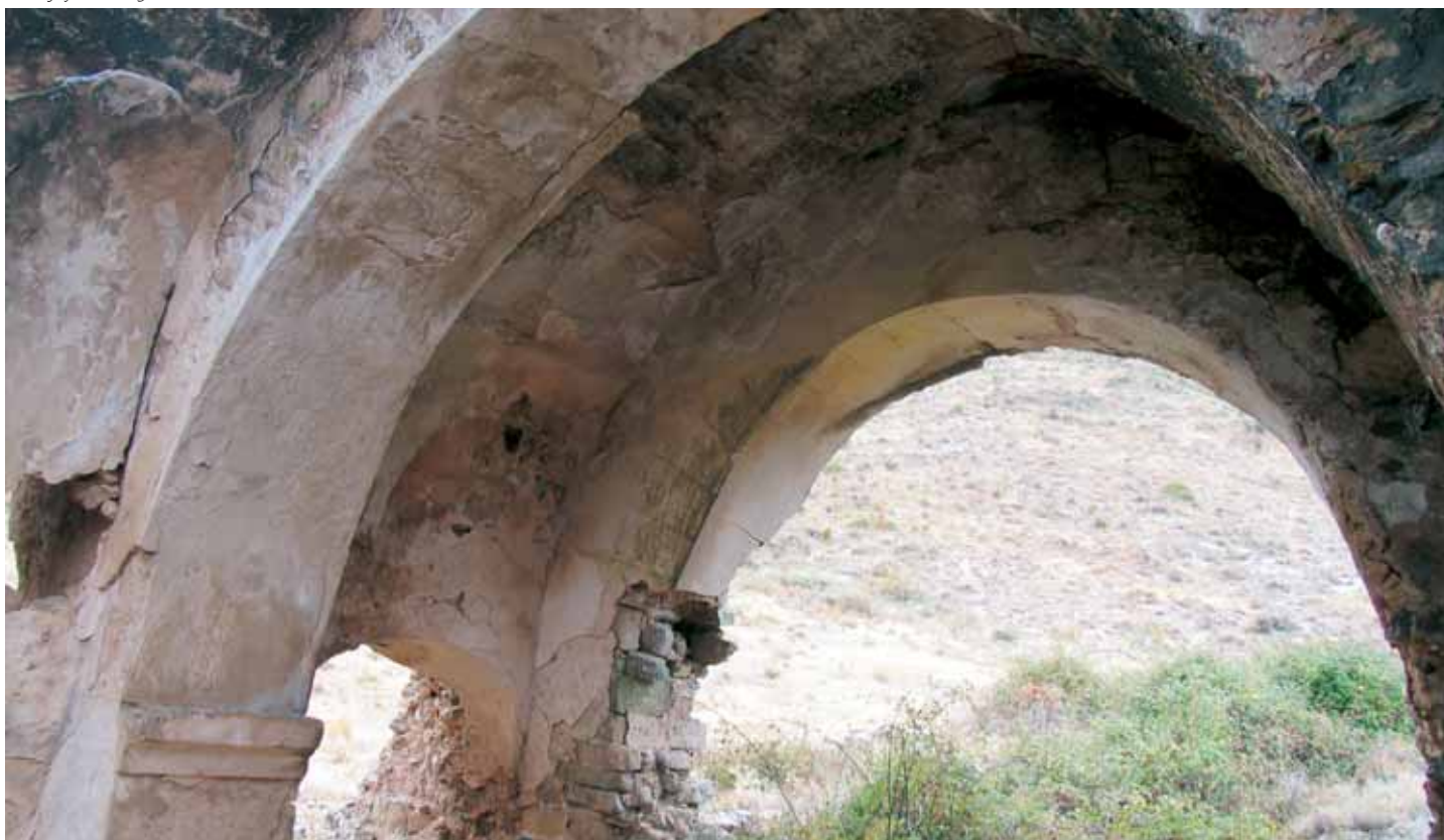
Arco fajón del segundo tramo
