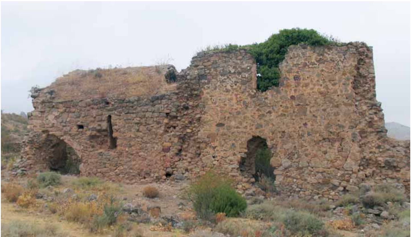
Ruinas de la ermita de Santiago, desde el Sur
