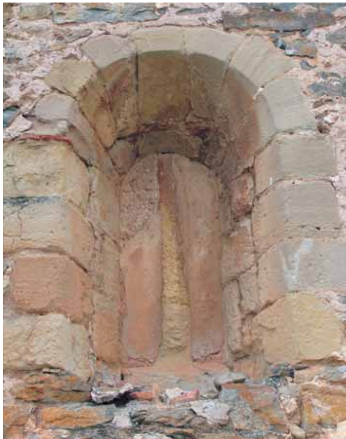
Vano en el muro norte de la nave
