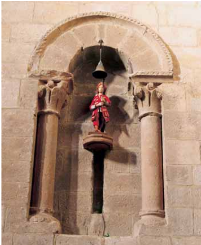
Ventana románica cegada. Parte inferior de la torre
