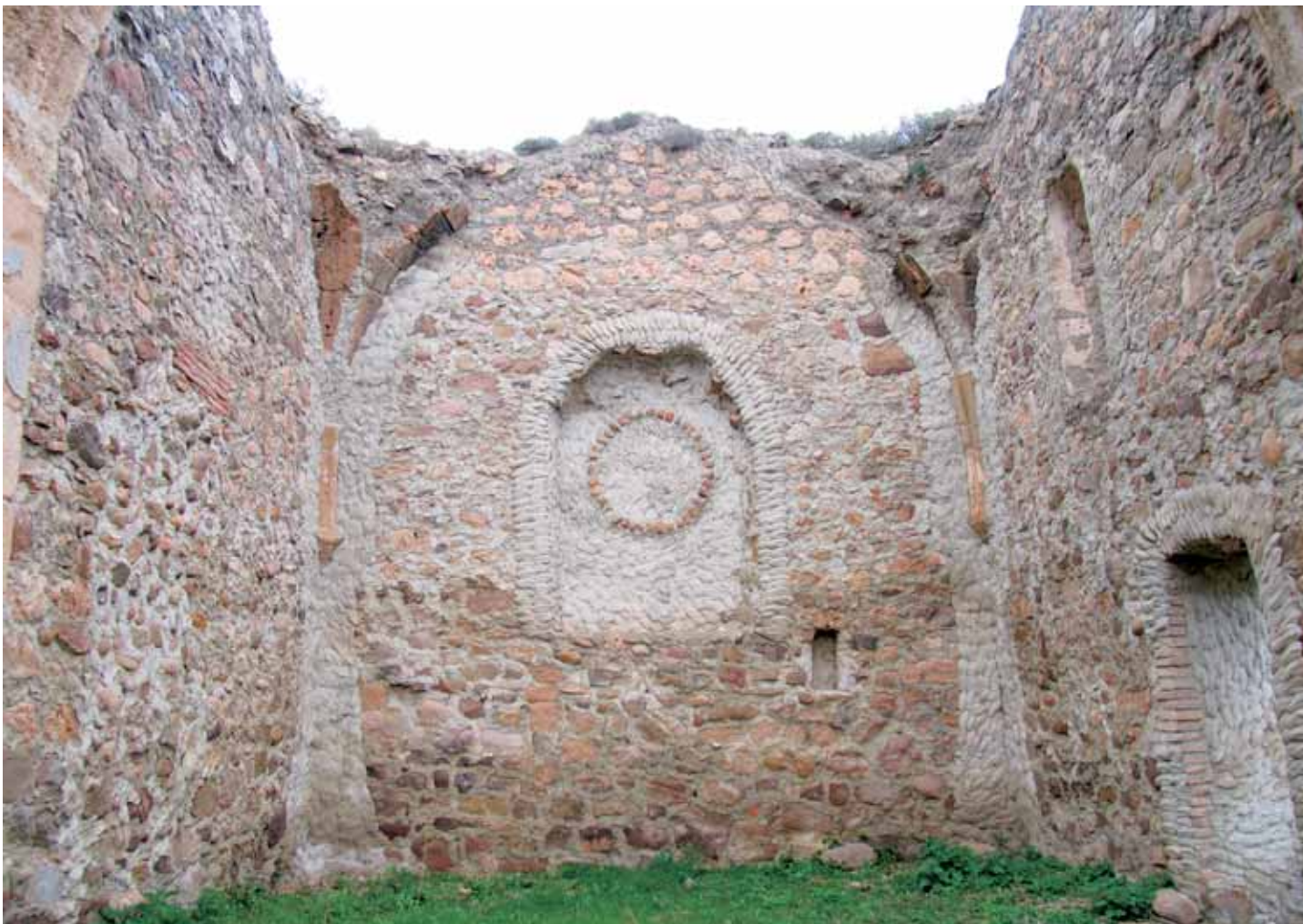
Vista del interior de la cabecera
