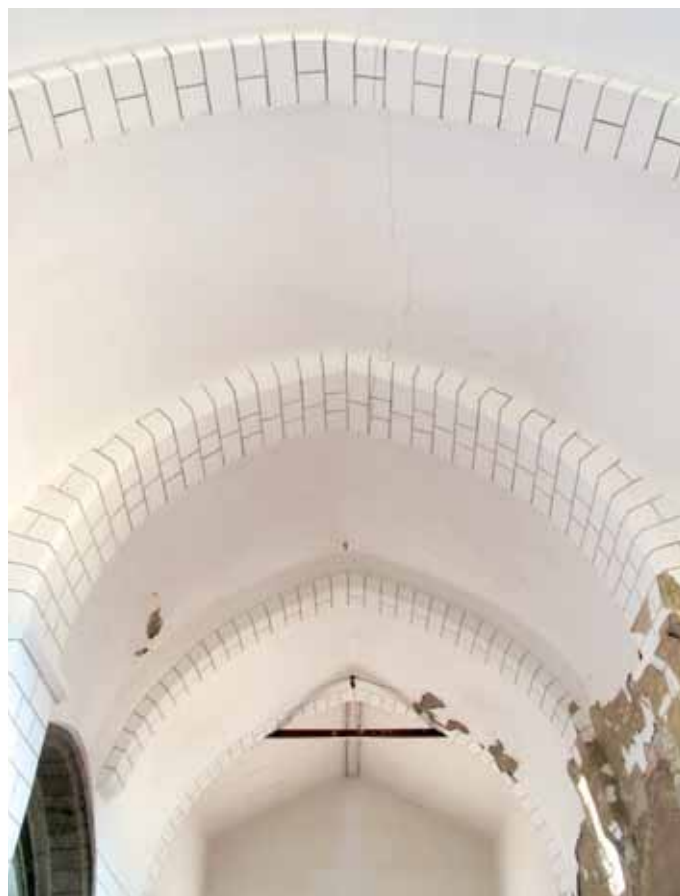
Bóveda del interior de la iglesia
