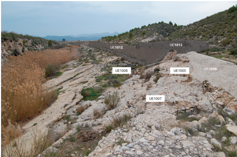
FIGURA 5 Aliviadero, boquera y partidur, y canal del azud de Román, UE principales
