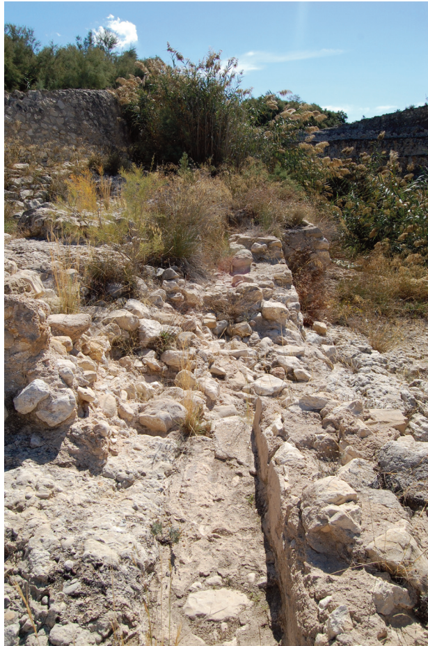
FIGURA 7 Restos del canal del cimbre
