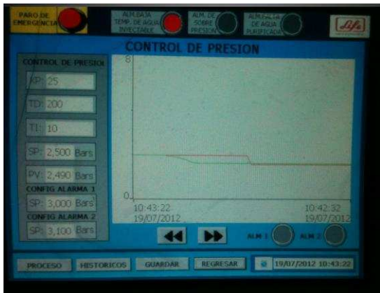
Fig. 19 Verificación del funcionamiento del Controlador PID de Presión
