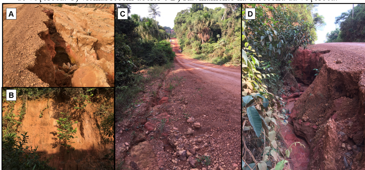
Figura 11 - Potencial erosivo alto a muito alto. A) Sulcos erosivos em vicinais. B) Parede de voçoroca. C) vicinal recém-aberto e D) Ravinamento na cabeceira da voçoroca.
