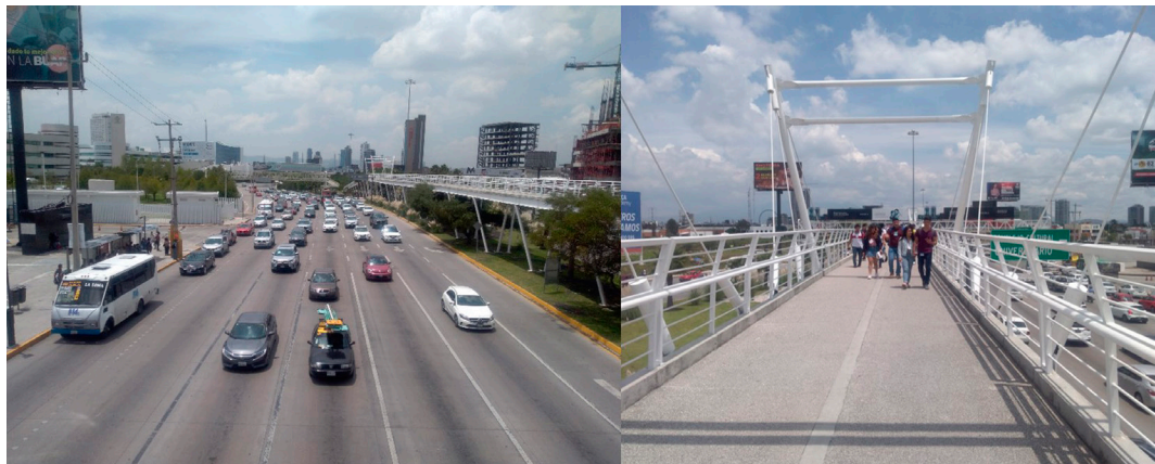
Figura 3: Obras implementadas en la zona de Angelópolis
