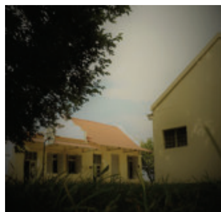
Imagen 1. Edificio del NRESO N° 1581
