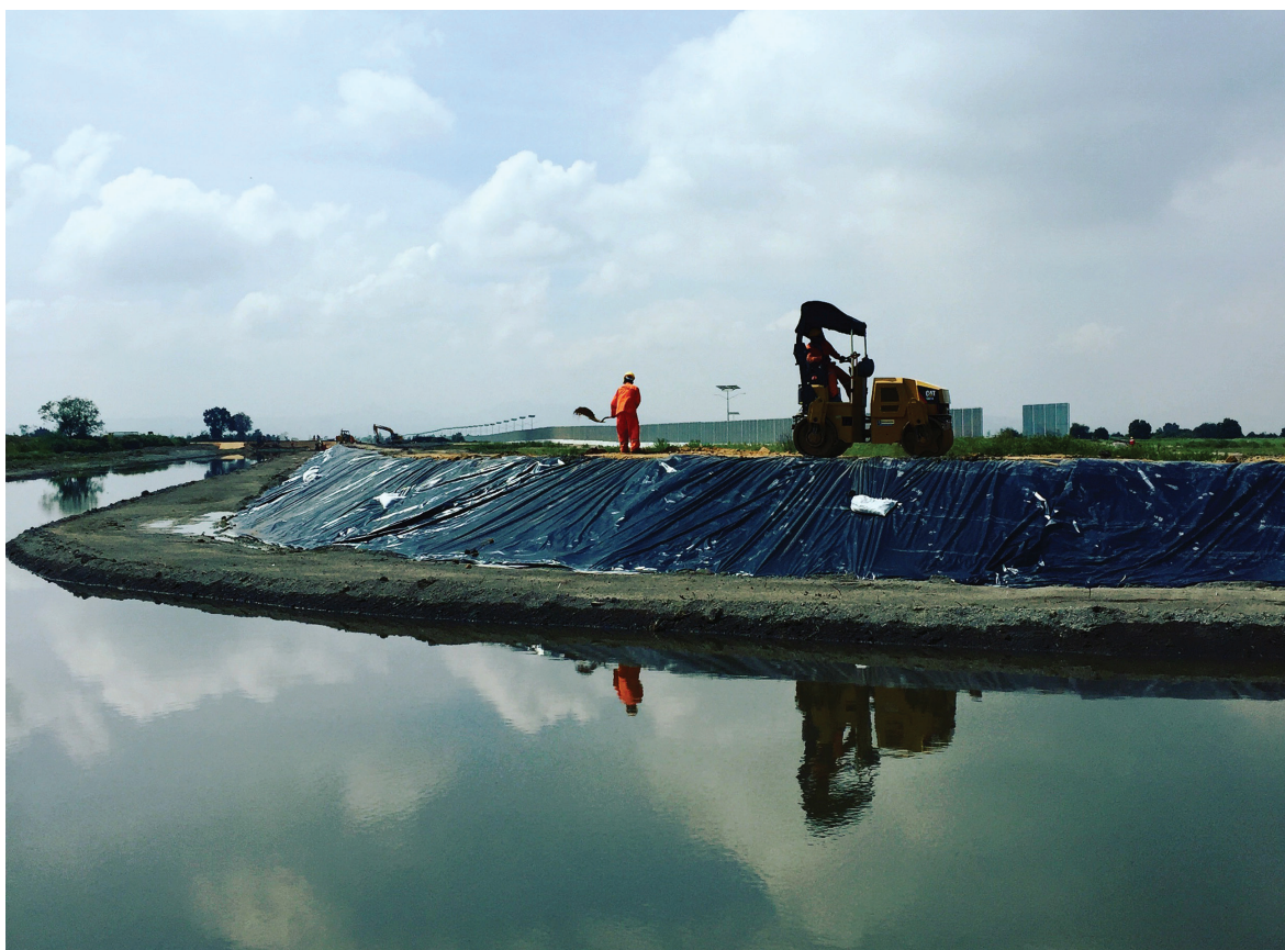
ARIADNA RAMONETTI LICEAGA ▶ Obras del Canal Colector del Oriente, sistema hidráulico que tenía como finalidad desviar los nueve ríos que desembocaban en el Lago de Texcoco a la laguna artificial Nabor Carrillo para que no se inundara el NAIM, San Salvador Atenco, Estado de México, 2016.
