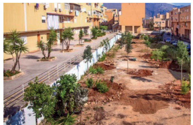
Fig. 4. Proyecto Diventare Giardino durante el proceso de intervención. Fuente: Manifesta 12.
