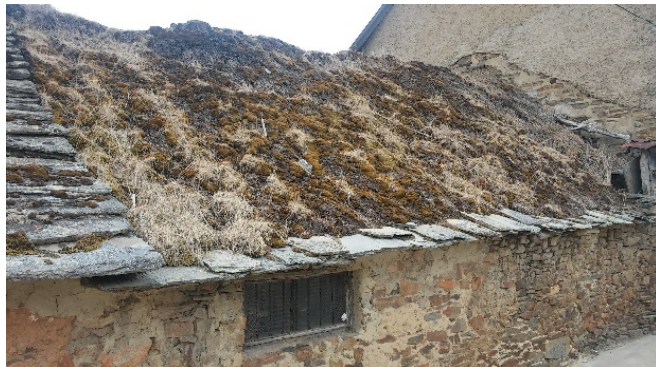
Fig. 12. Construcciones tradicionales en Lucillo.
