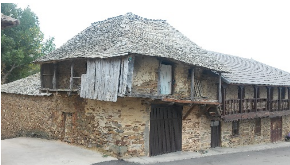
Fig. 13. Construcciones tradicionales en Lucillo.
