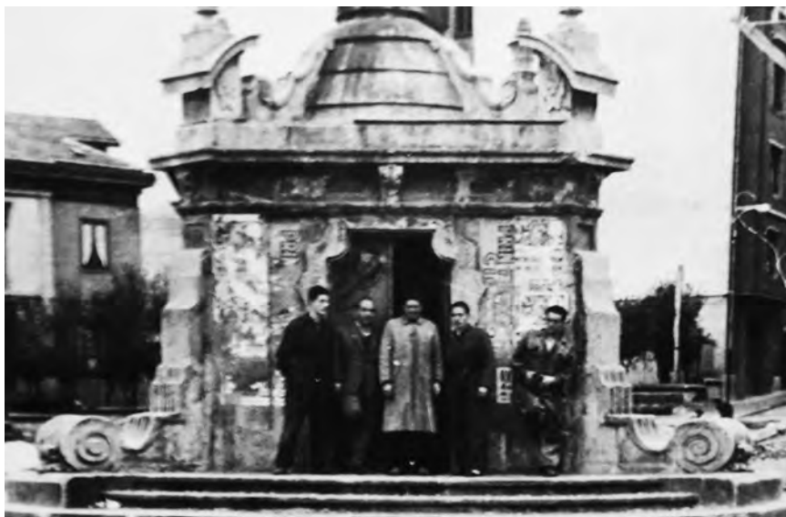
Subcentral de transformación eléctrica ( La Farola ), construida para suministrar energía a la red tranviaria.
