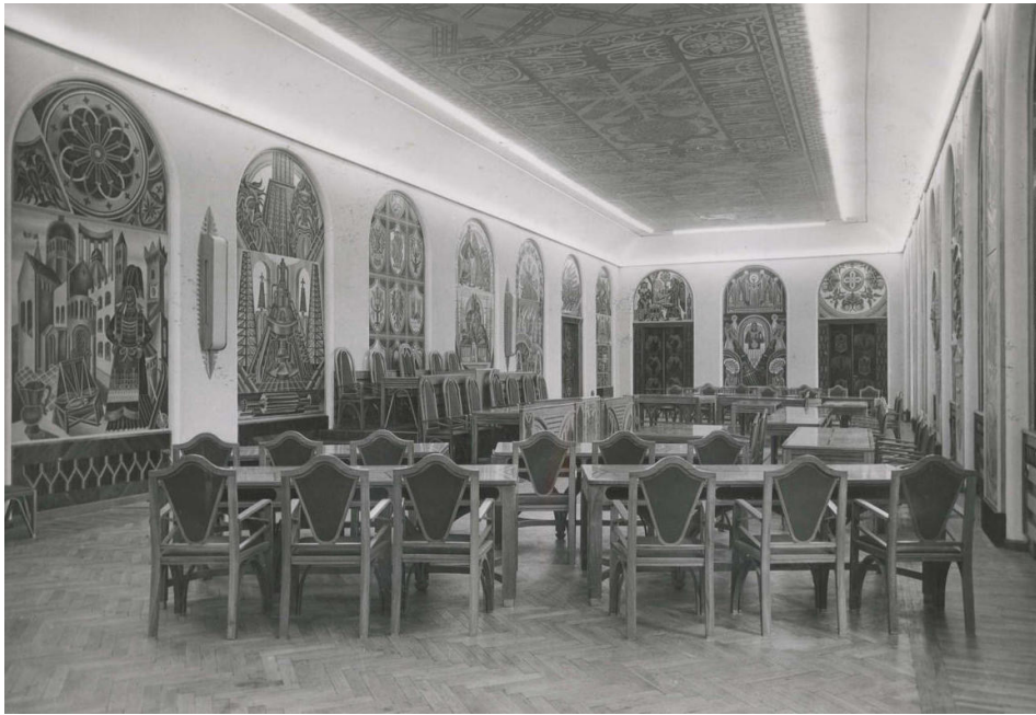
Figura 14. Sala del Consiglio del Palazzo della Provincia Autonoma de Trento (1953-1956).
