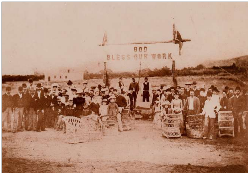
Colonia británica y autoridades insulares celebran inicio de las obras de construcción del puerto de La Luz. Las Palmas de Gran Canaria, 1883.
