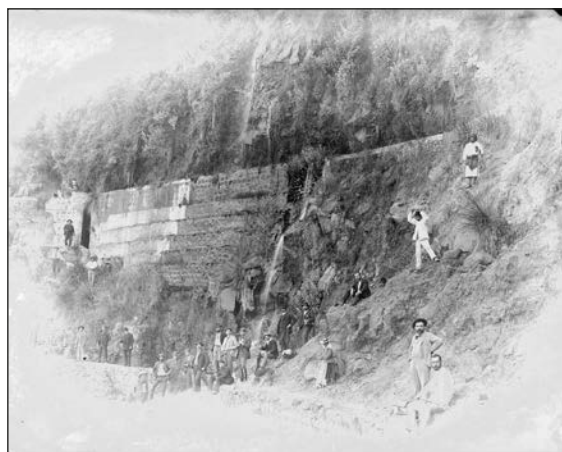
Rosendo Cutillas Hernández. Trabajos en las canalizaciones hidráulicas del barranco del Río, ca. 1900. Archivo General de La Palma, Fondo Rosendo Cutillas Hernández.
