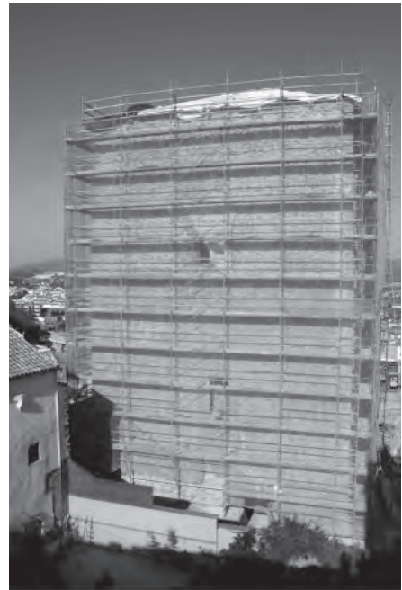
Torre del Homenaje en obras.
