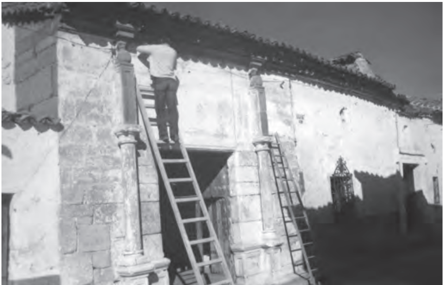
La imagen, de comienzos de los años 70 del siglo XX, nos permite comprobar cómo el llamado "callejón de la reja", en calle Mudo, núm. 3, era en origen una casa de estructura adosada a la Posada del Moro.
