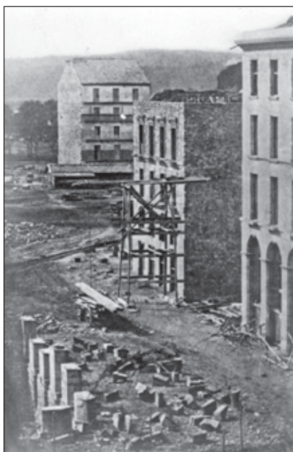
Construcción del Ensanche. Construcción de la calle Garibay donde se ven a la derecha la casa de don Martín de Oteiza llamada "El Café de la Marina", a continuación, el n.º 6 de esa calle; a la izquierda la casa de Cortázar, y al fondo, ya en la calle Andía, la parte trasera de la casa de Sebastián Arriaga. Kutxateca: 28173892.
