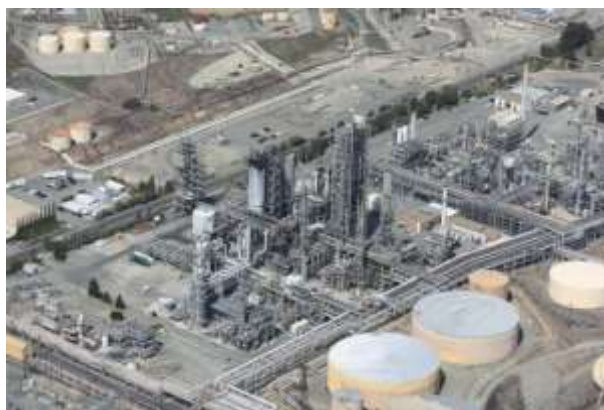
Figura 2:Planta de producción de hidrocarburos(Urzúla, 2013).
