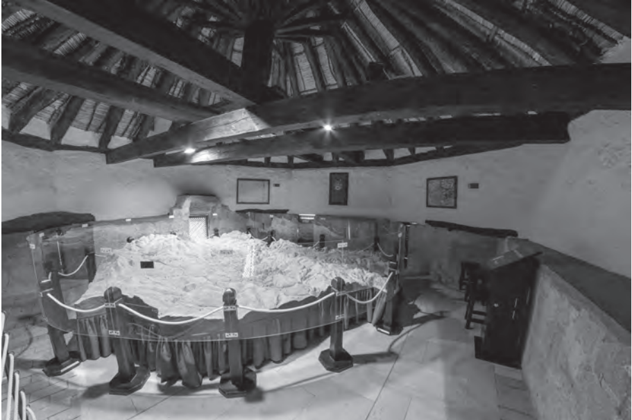
Vista de la sala 9. Sala de la Topografía. Maqueta municipal y cubierta de rollizos y vigas del siglo XVII.
