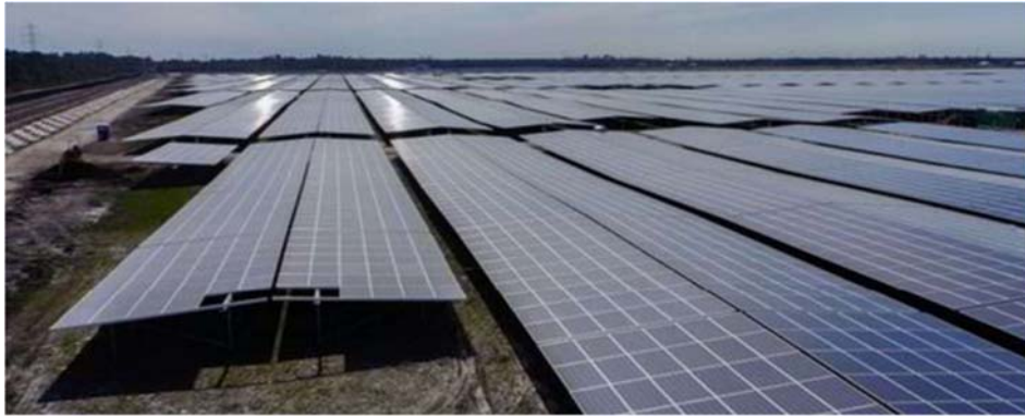
Fig. 2. Vista parcial de la planta Cestas [4].
