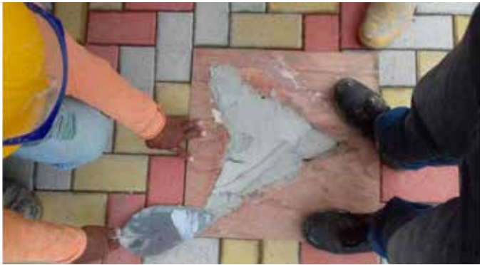
Figura 9. Colocación de una mezcla M3 como señalética en los exteriores del Poli-deportivo de Machala - Ecuador.
