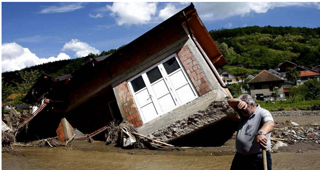
Figura 3. Casa arrancada por la fuerza del agua en Krupany (Serbia). Fuente: Marko Djurica
