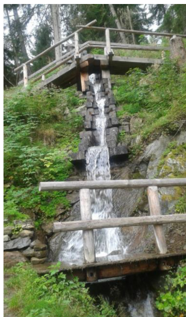
Figura 2. Bisse des Ravines. Bruson-Valais-Suiza. 2018.
