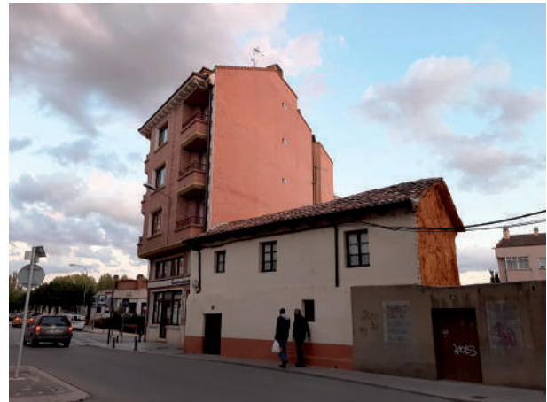
El cambio drástico de escala edificatoria es uno de los impactos que más afectan al conjunto urbano, como se comprende en este caso junto al final de la calle San Gregorio. Foto del autor, 2021.
