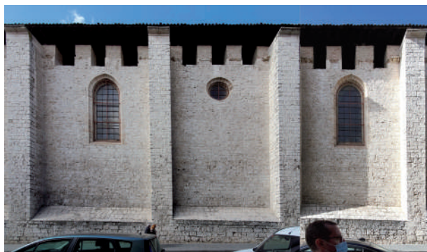
Fig. 13. Fragmento de la fachada oriental, en el que se aprecia el cuarto tramo de naves con un óculo y los dos contiguos con ventanales ojivales.
