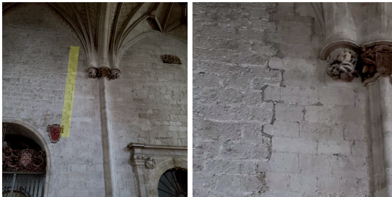
Fig. 3 y 4. Trabazón de fábricas entre el primer tramo y el segundo de naves del muro norte.
