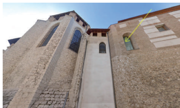
Fig. 27. Zona que ocupó el cubo del recinto del Alcázar en la calle Encarnación donde se aprecia el plano encajado del ábside del Evangelio y un ventanal practicado en el muro de ladrillo encima de la Sacristía para dar luz al ábside.
