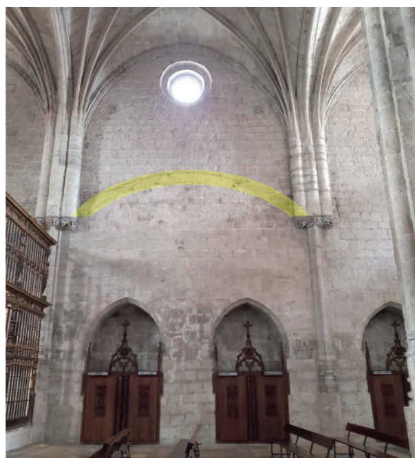
Fig. 5. Muro del cuarto tramo de la nave del Evangelio.
