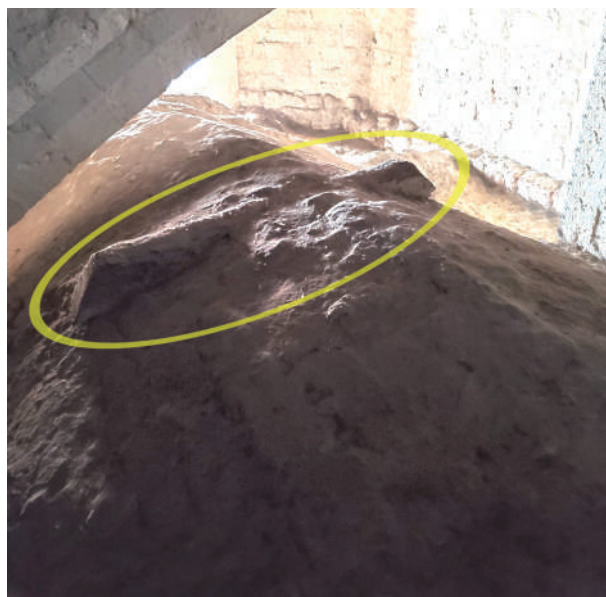
Fig. 22. Bajo cubierta de la cabecera del Evangelio. Viga trabada con la fábrica de la bóveda.
