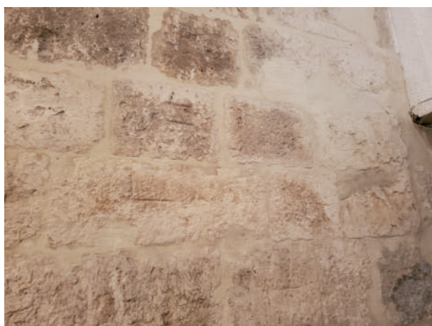
Fig. 14. Detalle del exterior del muro del Evangelio en la conexión con la residencial convento actual de los Carmelitas Descalzos, en el que se aprecian marcas de cantería medievales.
