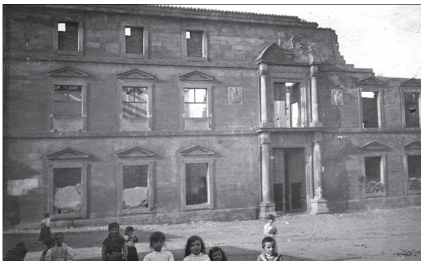
Lám. 9. El palacio Roco-Campofrío en estado a abandono a comienzos del siglo XX.
