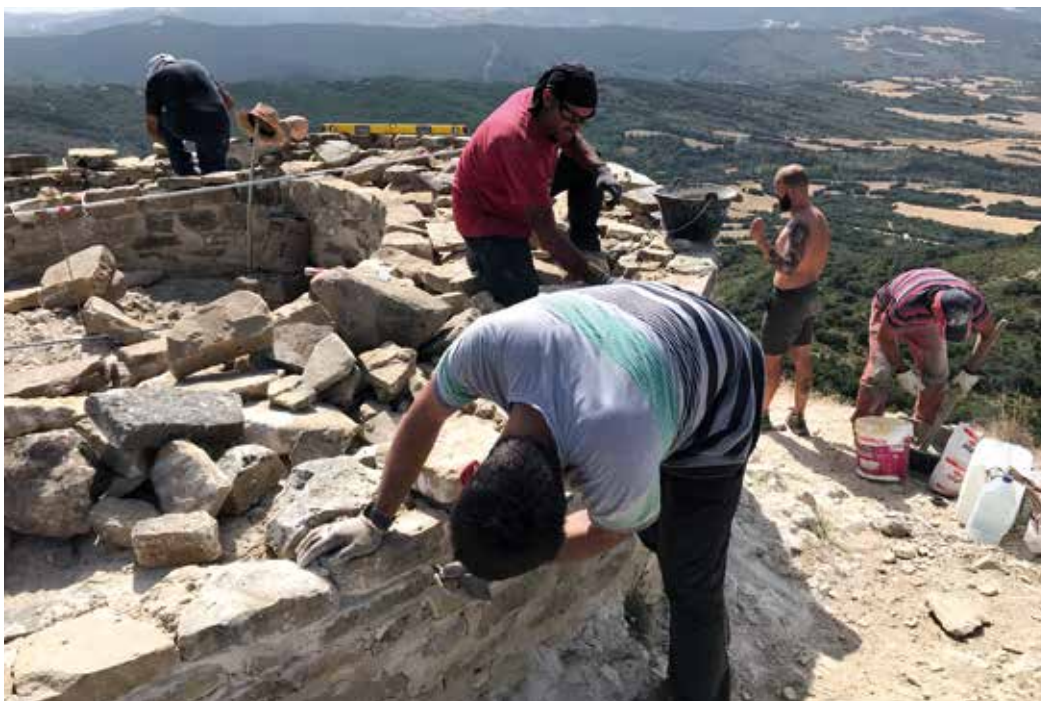
Figura 4. Torre. Proceso del rejuntado.
