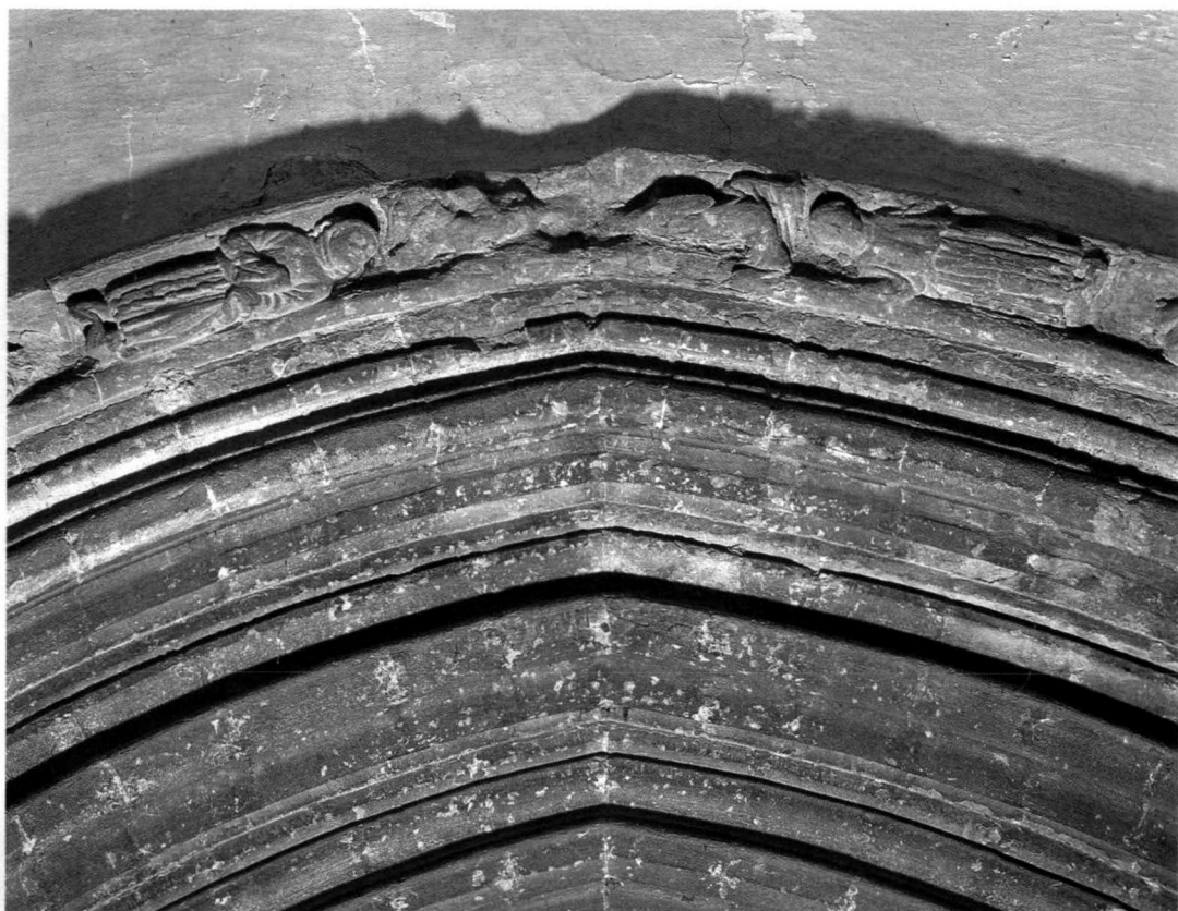
Puerta de la Bendición. Arquivolta exterior, zona de la clave. Juan de Leredo, 1461-1462. Foto Antonio Ceruelo.
