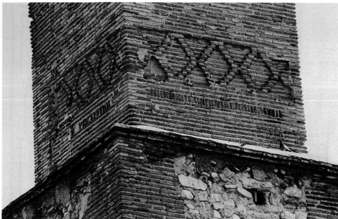
Torre campanario. Detalle.
