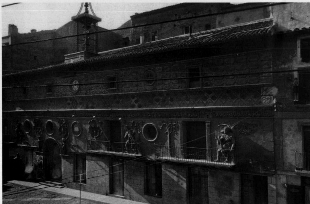
20. Estado de la fachada del Ayuntamiento de Tarazona antes de la "reconstrucción" de Fernando Chueca Goitia. Fotografía fechada a mediados del siglo XX.
