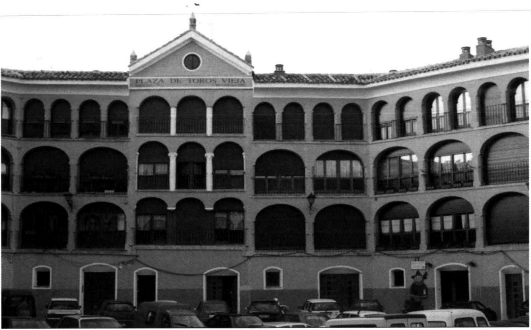
17. Plaza de Toros Vieja después de la restauración.
