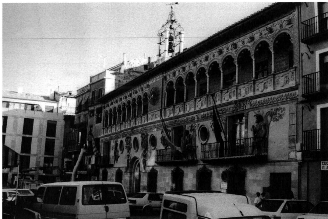
21. Estado actual de la fachada del Ayuntamiento de Tarazona.
