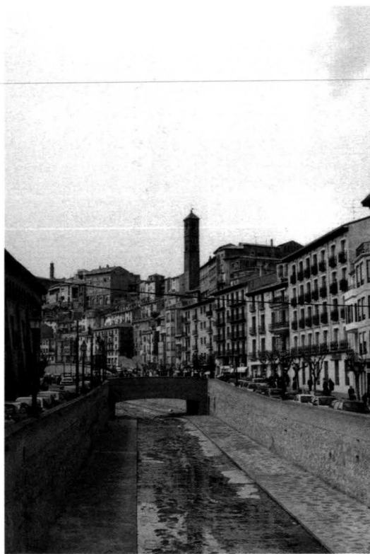
3. Vista del río Queiles a su paso por Tarazona en la actualidad.
