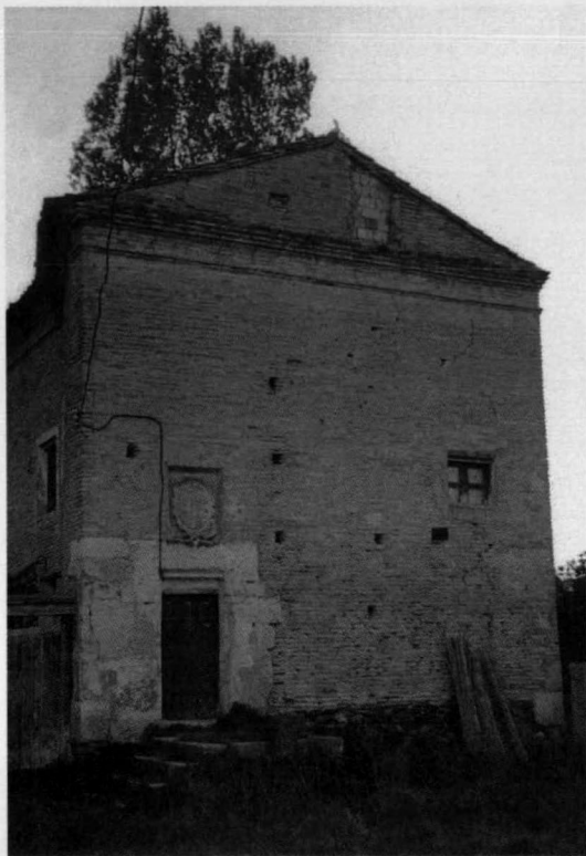
8. Fachada principal de la Casa de la Rudiana. Estado actual.
