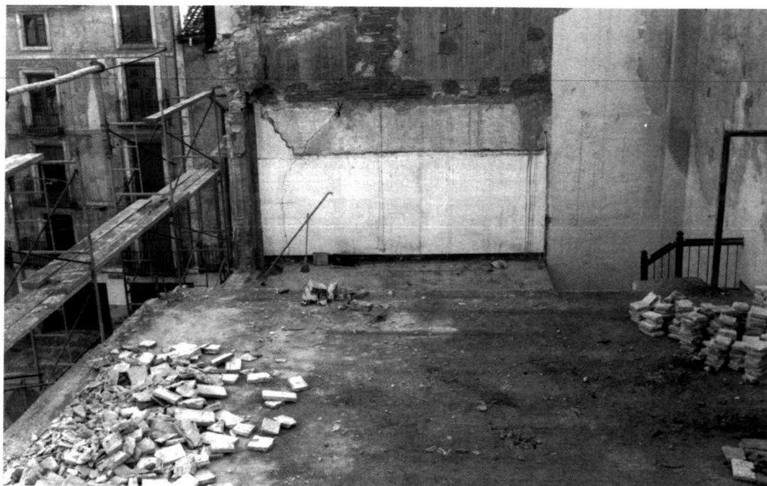
Imagen del edificio durante los trabajos: última planta tras la demolición. Foto: Juan Asensio.
