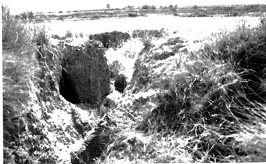
FOTO 6. Salida de "pipe" y hundimiento superficial.
