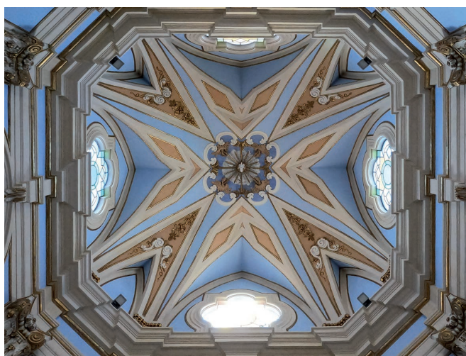
Fig. 1. Copertino (Lecce). Chiesa di San Giuseppe da Copertino, volta (foto di F. Suppressa).
