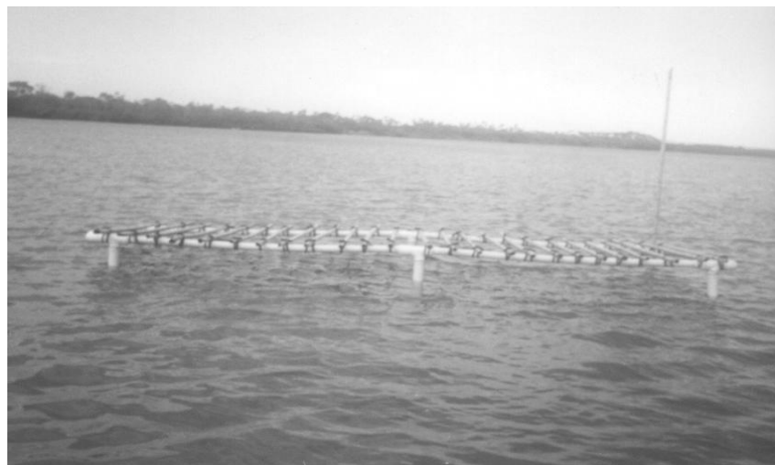
Figura 7- Mesa de cultivo em PVC e concreto utilizada em Fortim.
