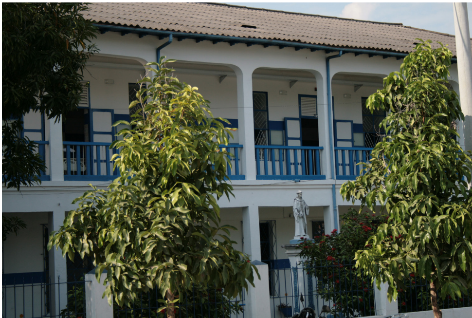
Figura 4: Fachada principal del Hospital Herrera Restrepo Fuente: Carlos Eduardo Nieto, 2018
