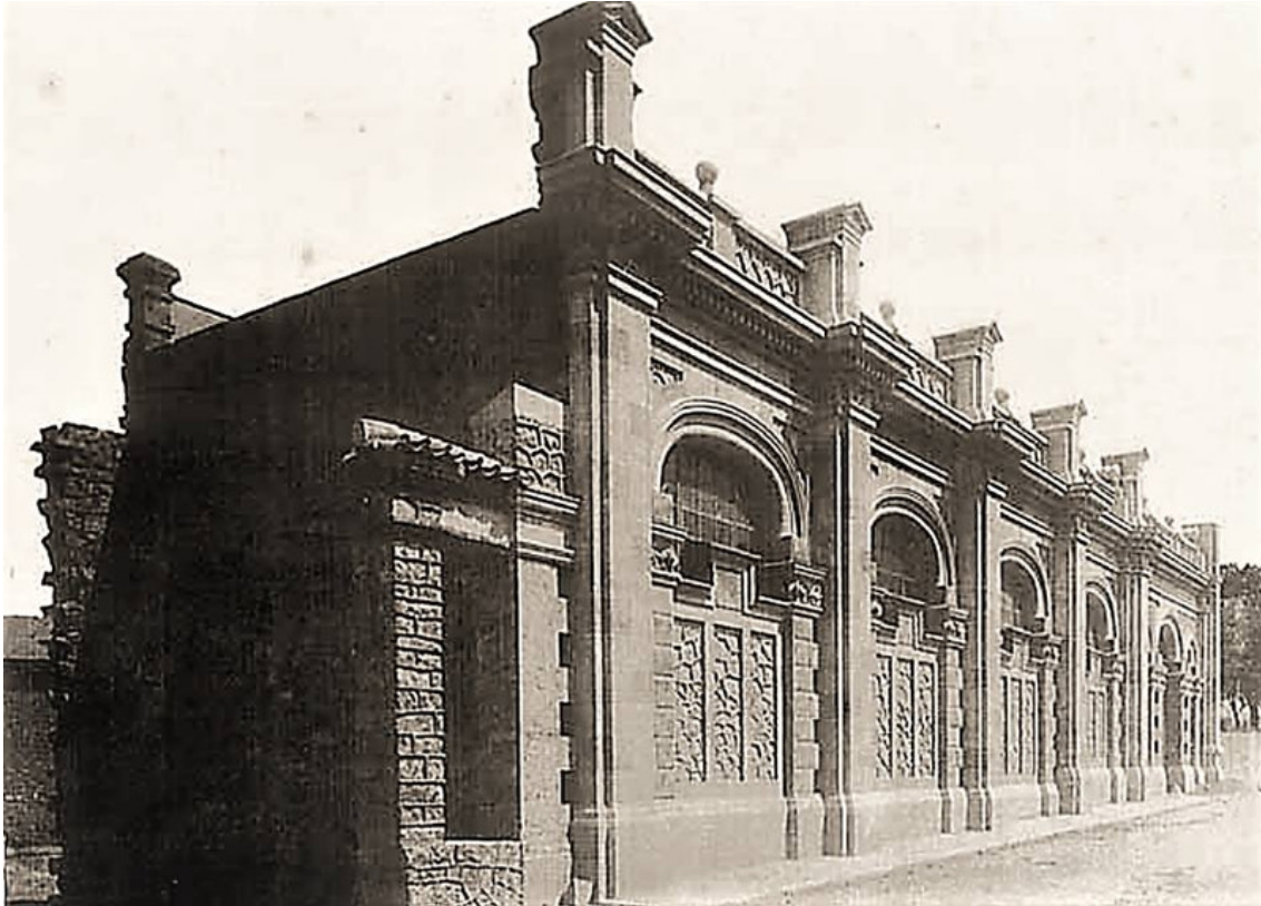
Fachada de la fábrica de perfumes 32 al Camino de la Estación (Foto RedJaen).
