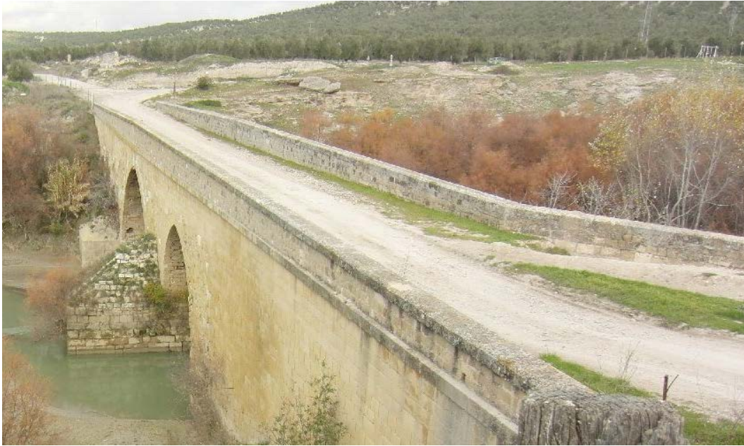
Puente de Úbeda la Vieja o Puente Viejo.
