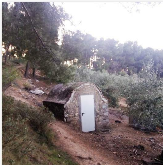
Caseta repartidor de la Fuente del Alamillo
