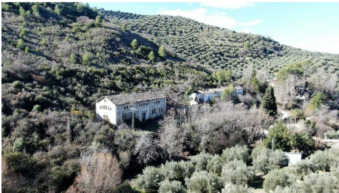
02_02_Vista aérea conjunto central, escuela y poblado (oeste).
