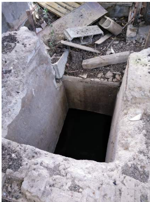
02_10_ Acceso al foso de las turbinas desde la sala de máquinas de la central.
