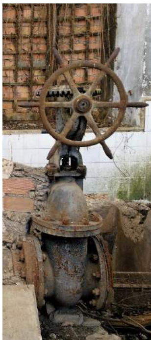
02_17_ Válvula de compuerta de corte y regulación con bridas.
