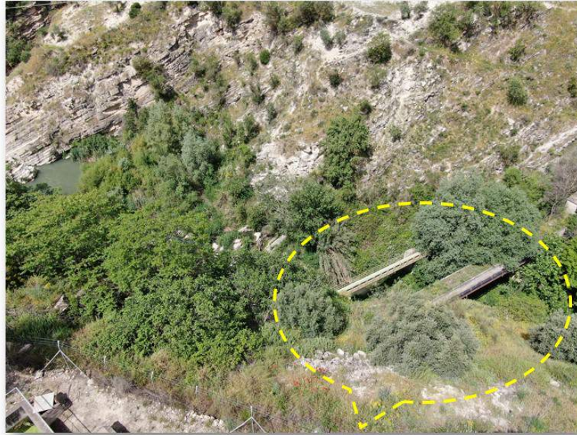
Paso aéreo de las conducciones de aguas de Los Villares (izq.) y del Quebrajano (der.) sobre el río Eliche (Cota +595) (mayo 2022)
