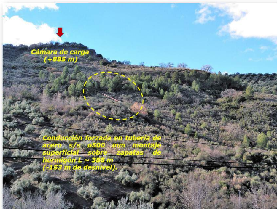
Vista aérea conducción forzada
