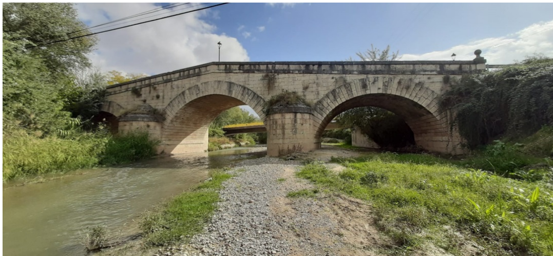
Fotografía actual del Puente Tablas
