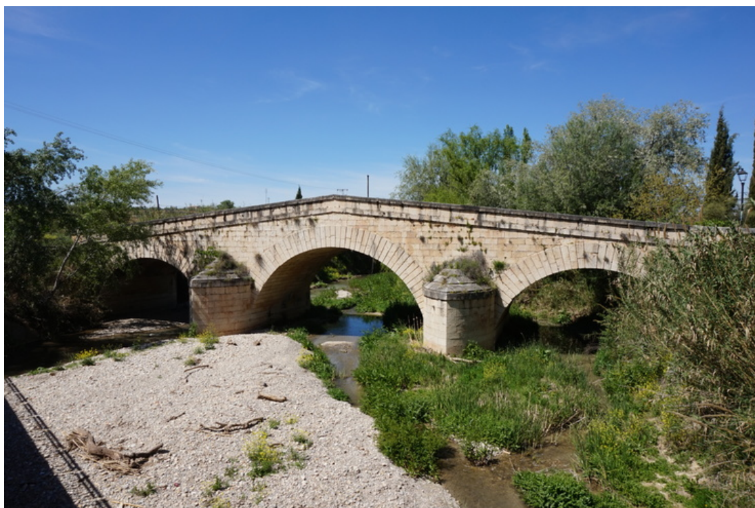
Fotografía actual del Puente Tablas
