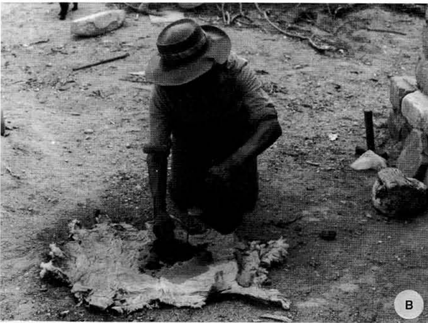
Figura 4. A: Preparación de la masa. B: La pirca molida es mezclada con barro desleído en agua para formar el amasijo, que tras días de descanso resulta operable y constituye el bolo o masa.
