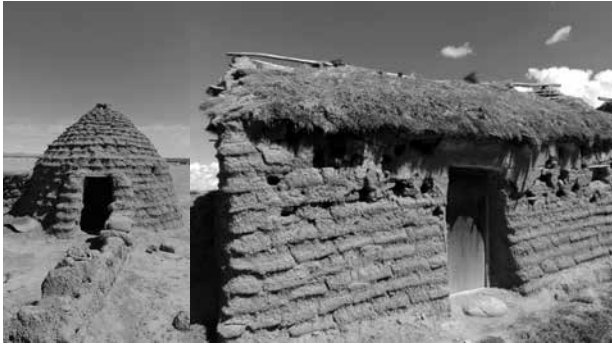
Figura 6. Putuku en Qulqiamaya construido con ch'ampas , donde los muros continúan para conformar el cerramiento del elemento. Muro del taru uta en Jach'a Chambi construido con ch'ampas , por la pérdida del revestimiento se observa la disposición de las piezas con las raíces hacia arriba. Fuente: elaboración propia.
