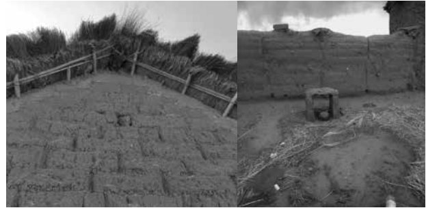
Figura 7. Muro de adobe en el taru uta ; tapia en el uta anqa . Fuente: elaboración propia.
