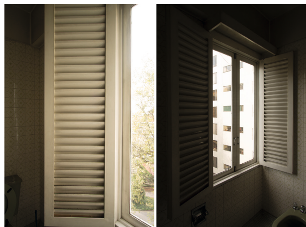
Figura 8. Las persianas metálicas. Fuente: elaboración propia.
